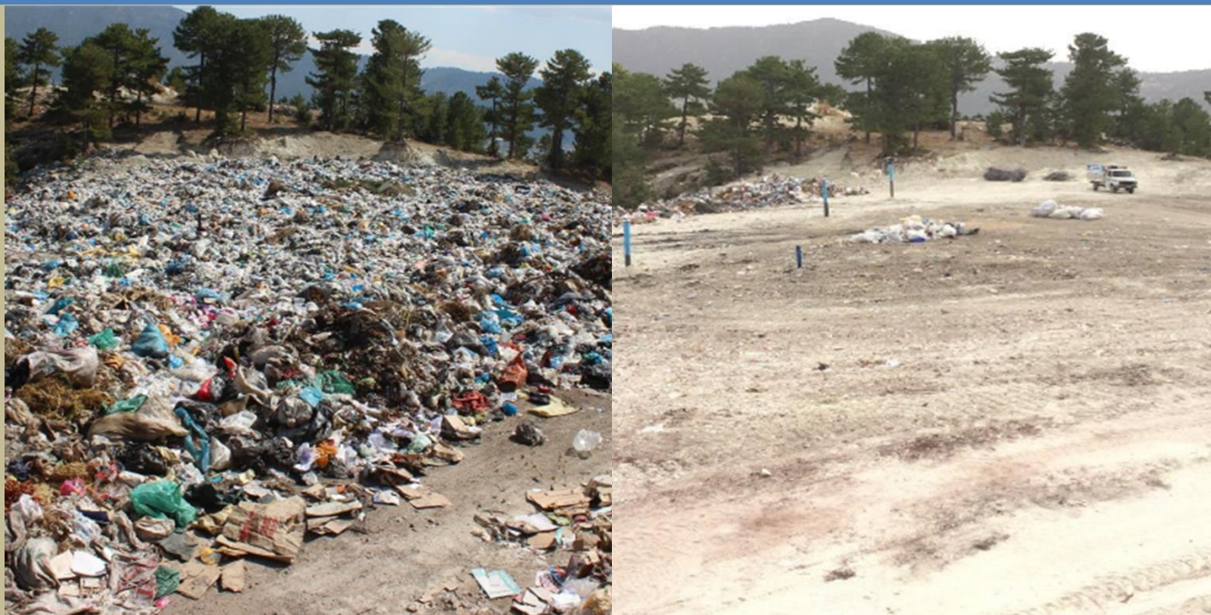
Depozit de deșuri neconform înainte și după reabilitare (Cameli, Denizli, Turcia)
